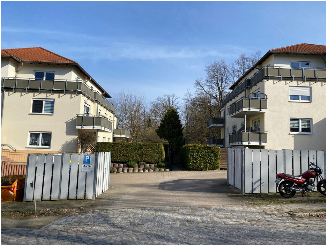
PKW Zufahrt zum Objekt
