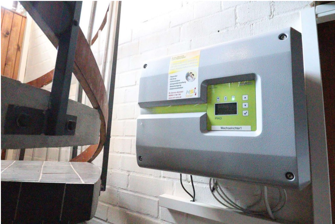
Photovoltaik-Steuereinheit
