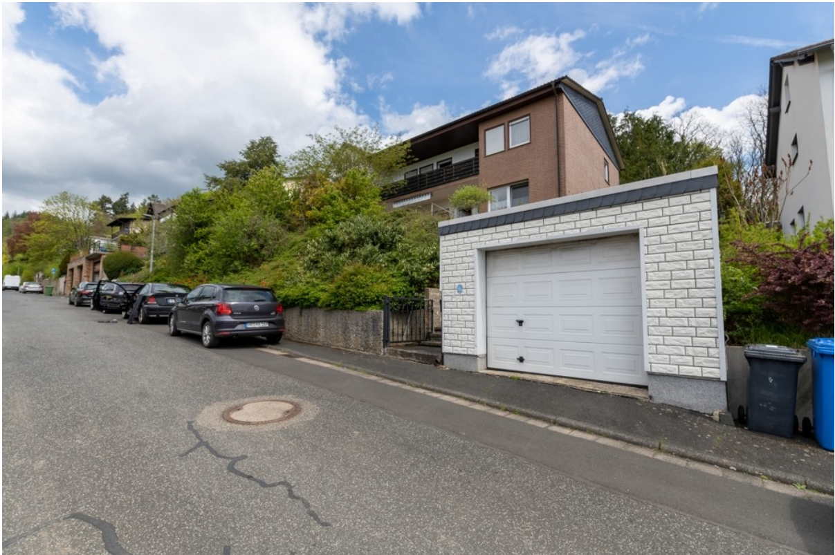
Ansicht von der Strasse
