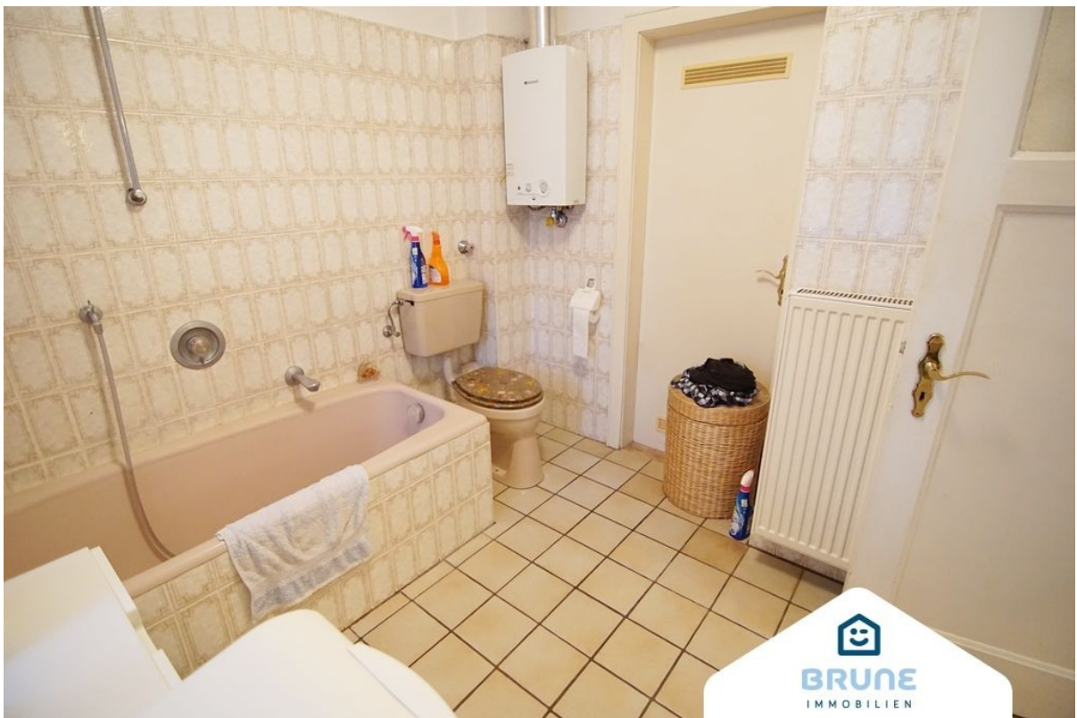
Bad WHG 1. OG, Haus 106
