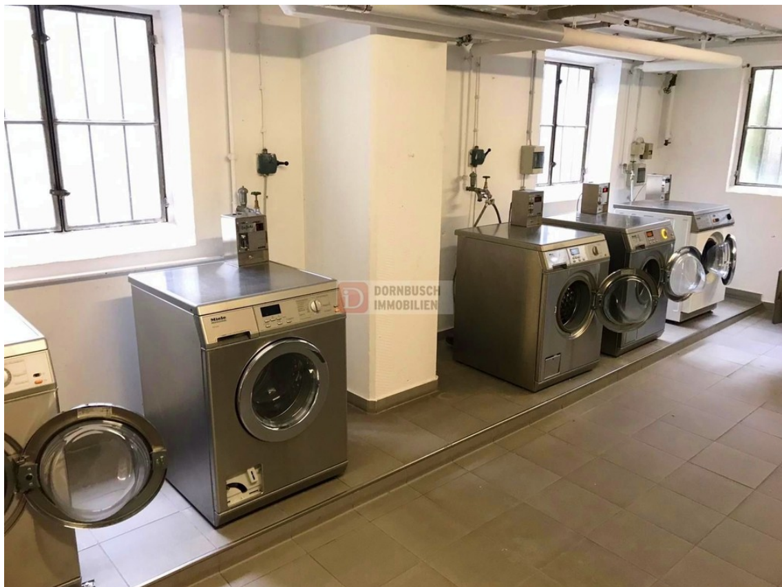
Waschküche im Keller
