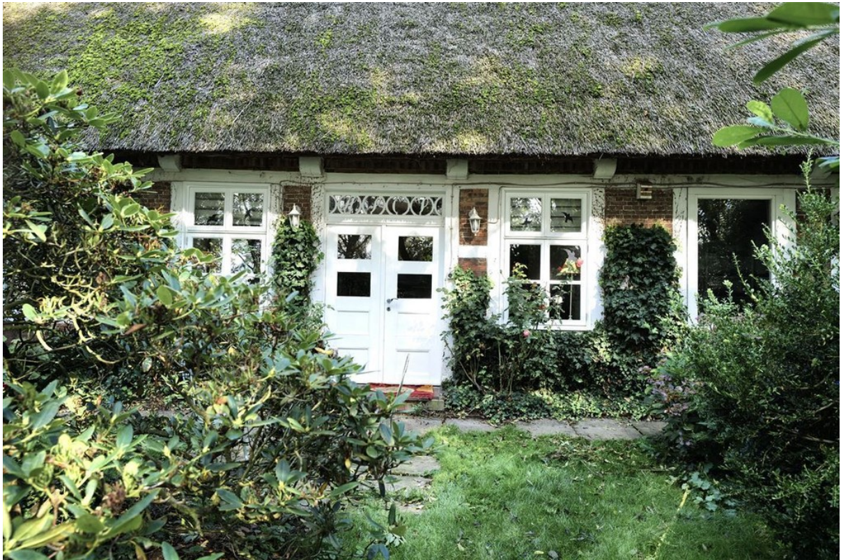
Nebeneingang in den Garten
