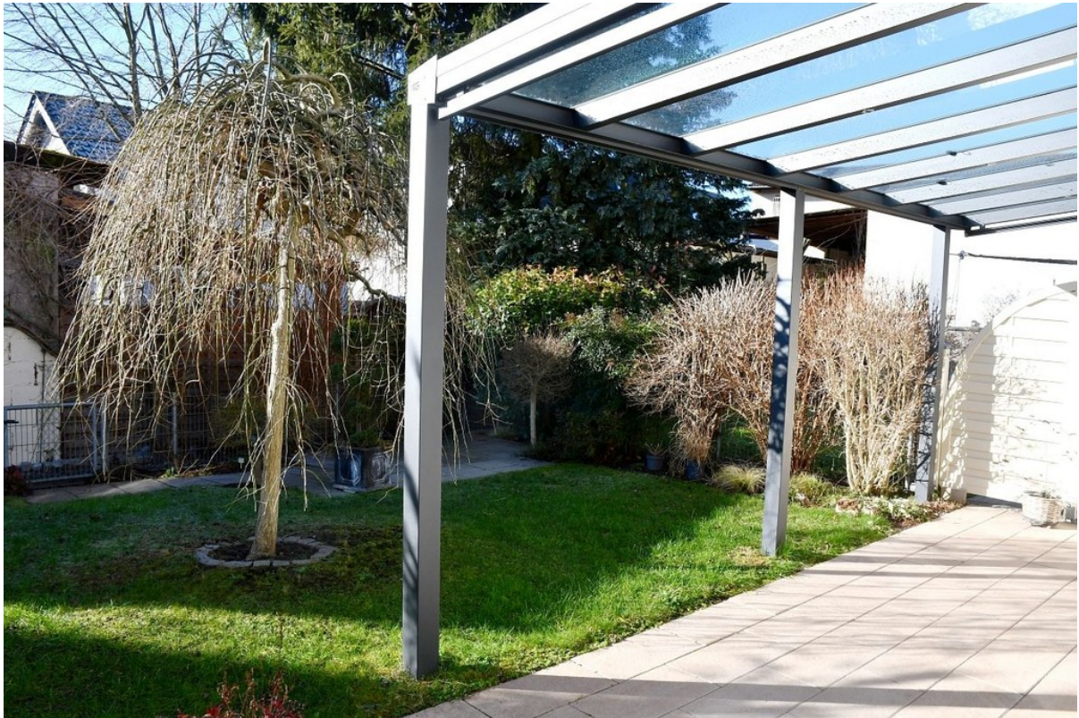
Sonnenterrasse mit Überdachung
