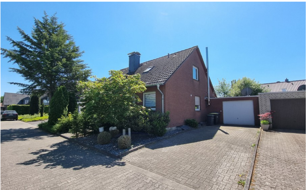
Seitenansicht mit Garage
