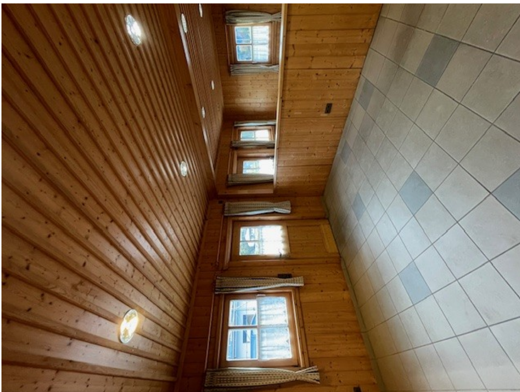
Raum im Nebengebäude
