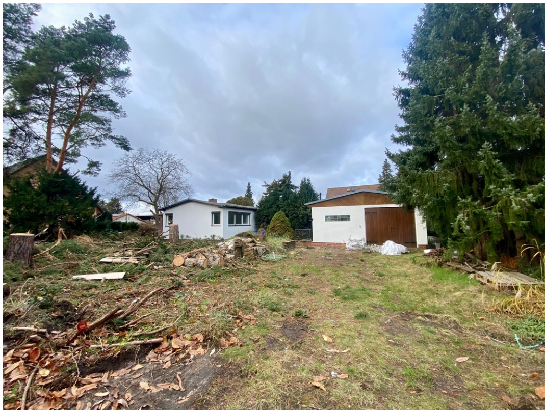
Ansicht Grundstück Haus und Ga
