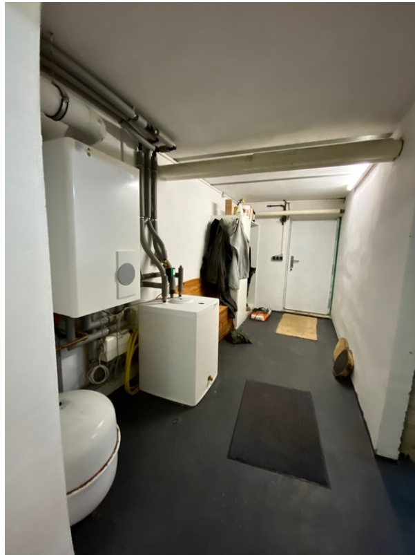
Flur und Zugang Kelleraussentr
