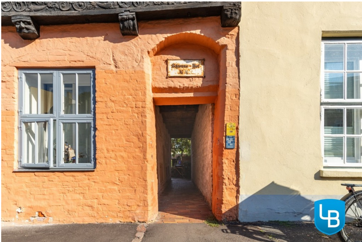
Durchgang zum Hauseingang vom
