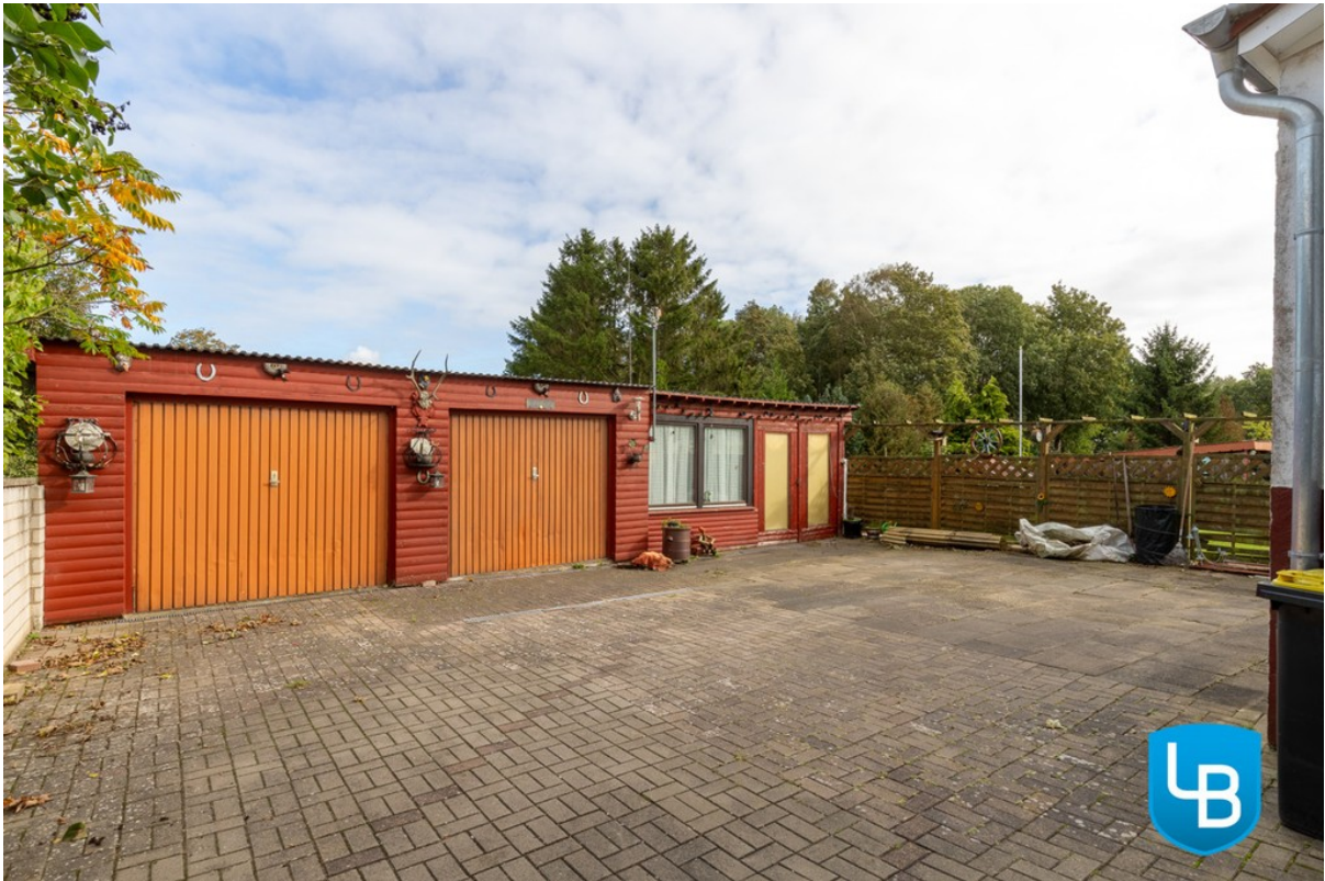
Hinterhof mit Doppelgarage
