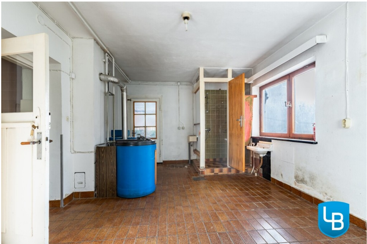
Heizungsraum mit Dusche
