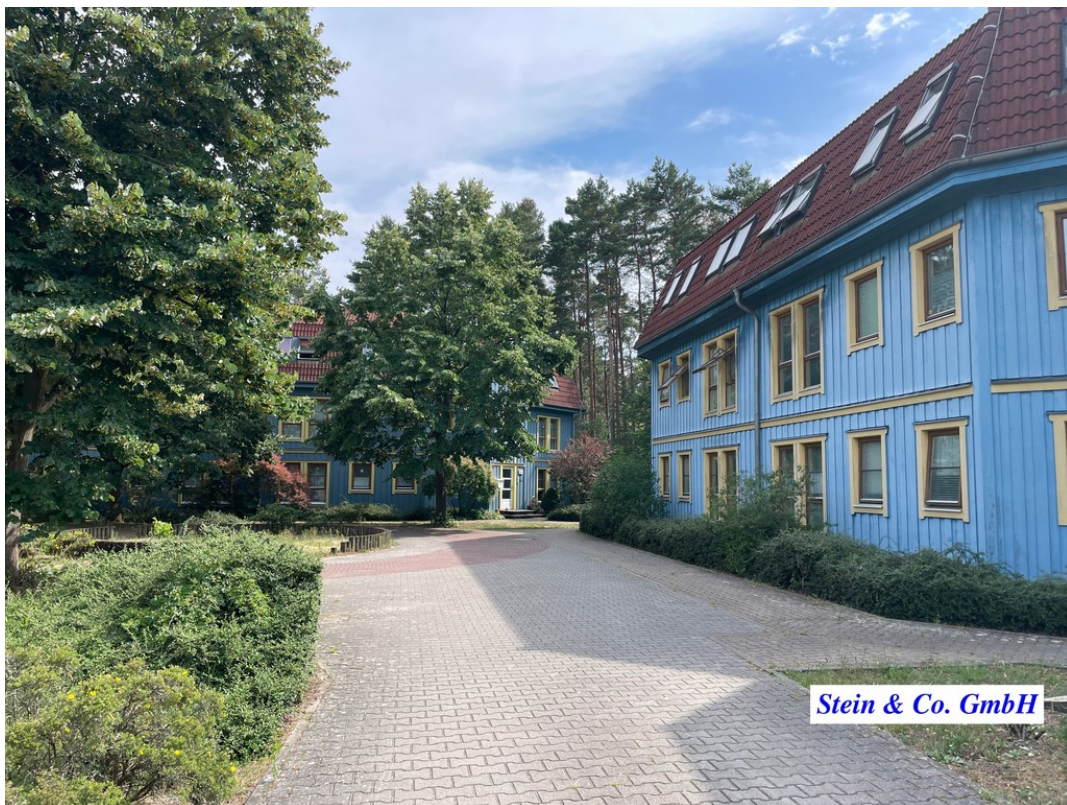
Zugang zum Objekt
