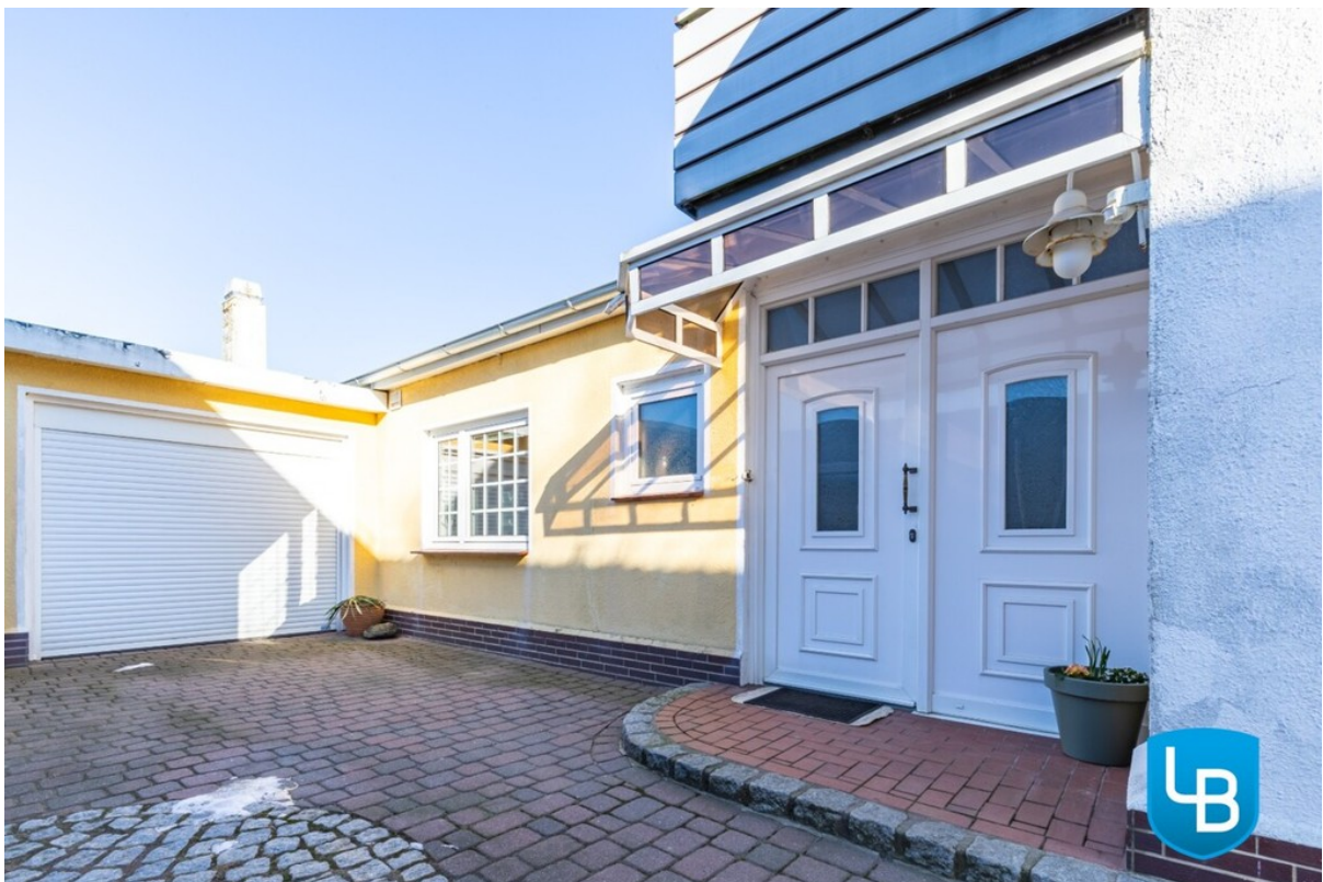
Hauseingang und Zufahrt Garage
