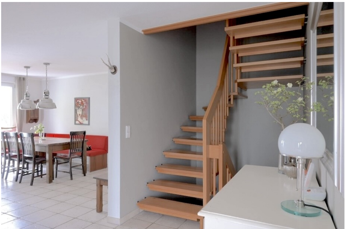
Massive Holztreppe ins Oberges
