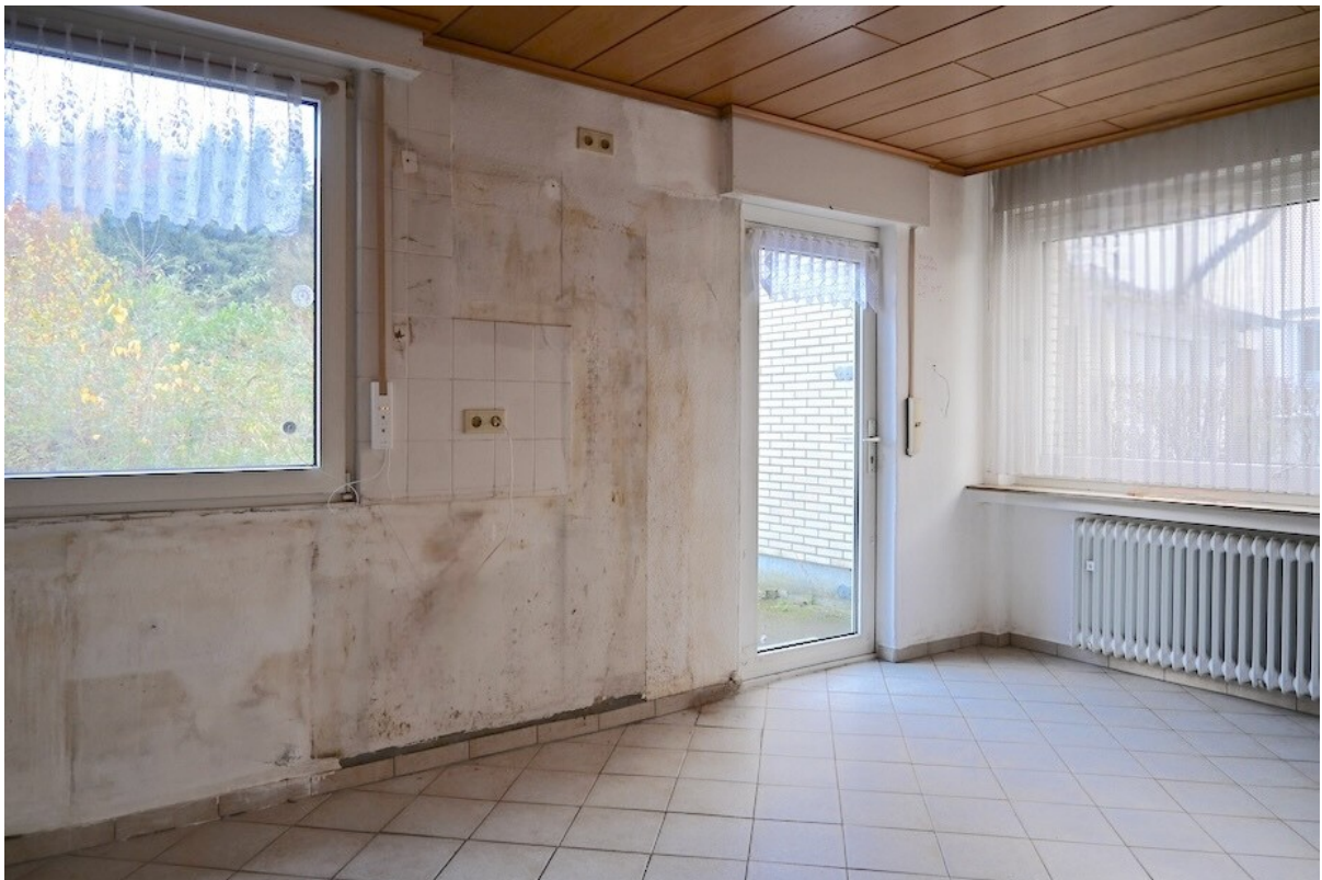
Küche mit Zugang auf die Terra
