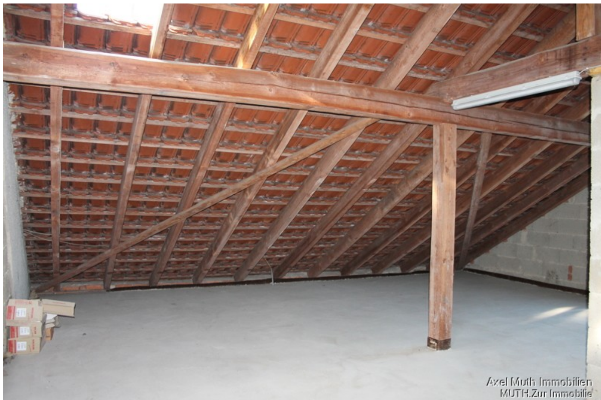
Ausbaureserve im Dachgeschoss
