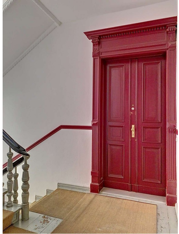
Detail Treppenhaus Vorderhaus
