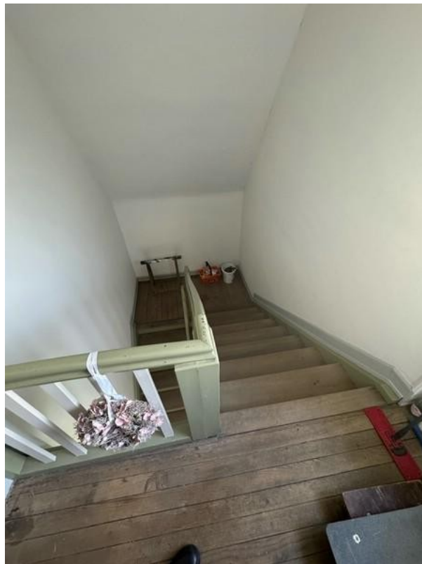
23 Treppenhaus zum KG und zum
