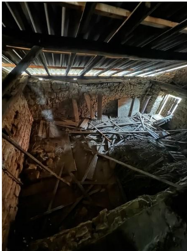
2 OG und Dach (5)
