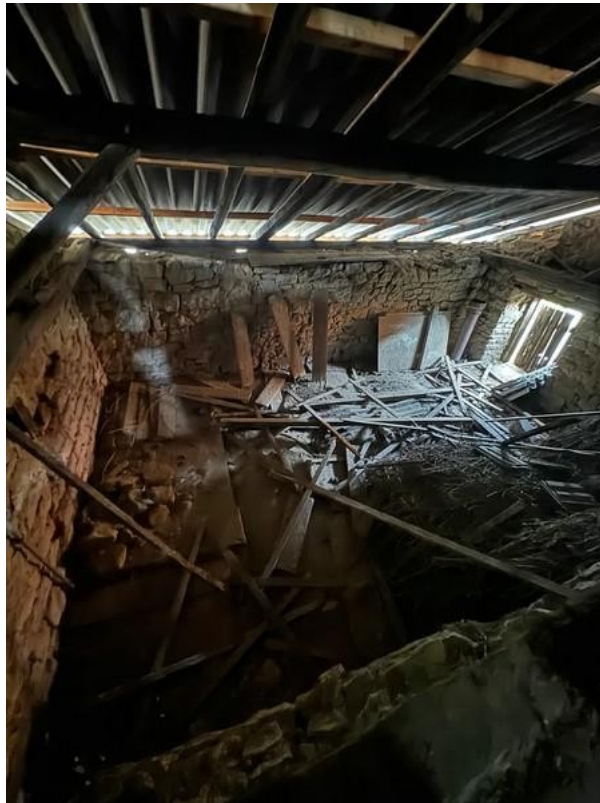
2 OG und Dach (5)
