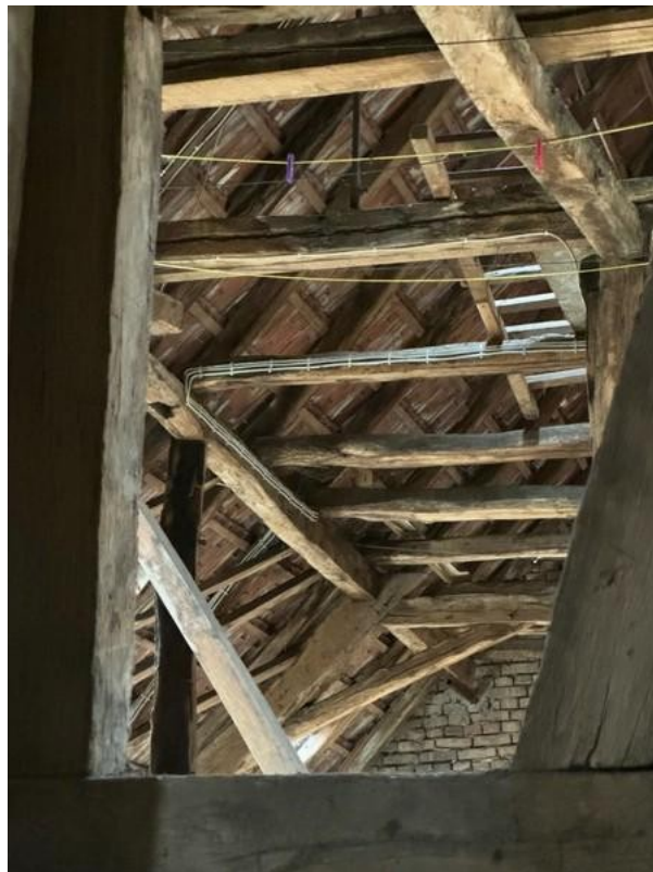
2 OG und Dach (4)
