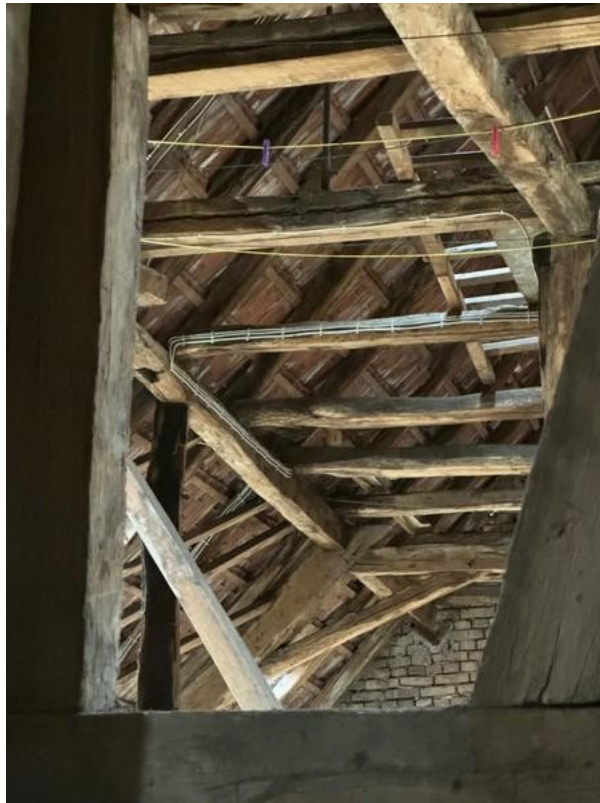
2 OG und Dach (4)
