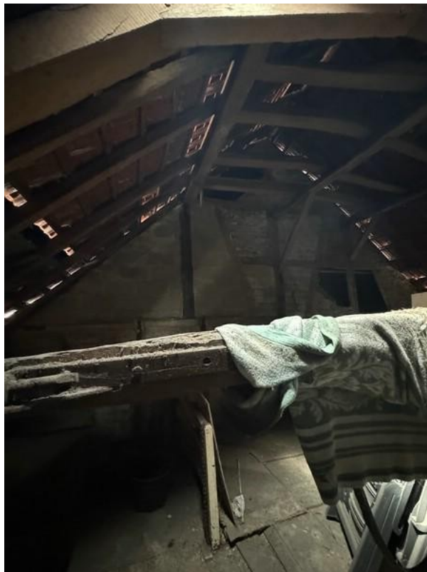
2 OG und Dach (2)
