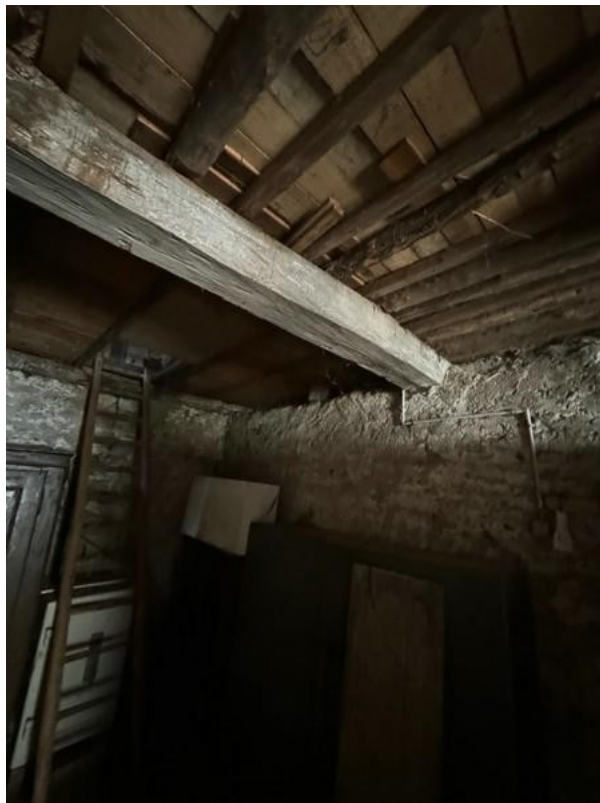
2 OG und Dach (1)
