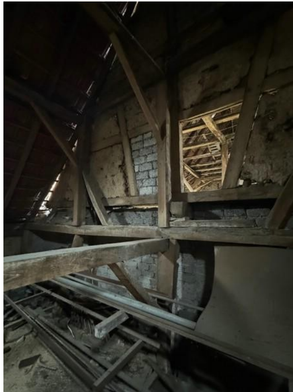
2 OG und Dach (3)
