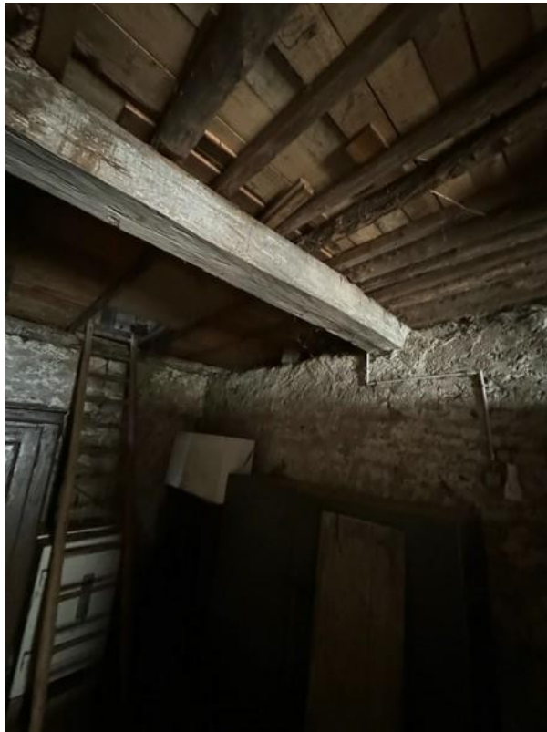
2 OG und Dach (1)
