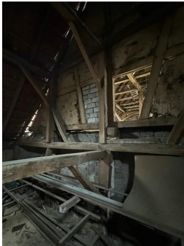
2 OG und Dach (3)
