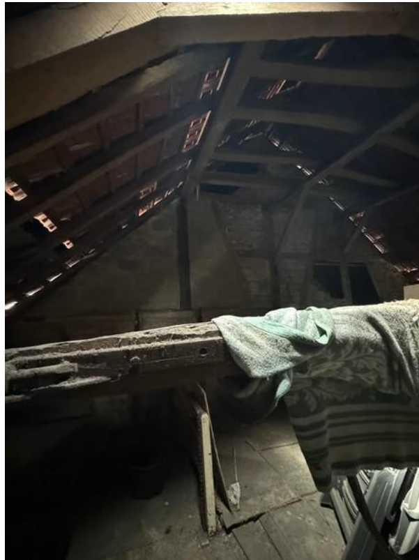
2 OG und Dach (2)
