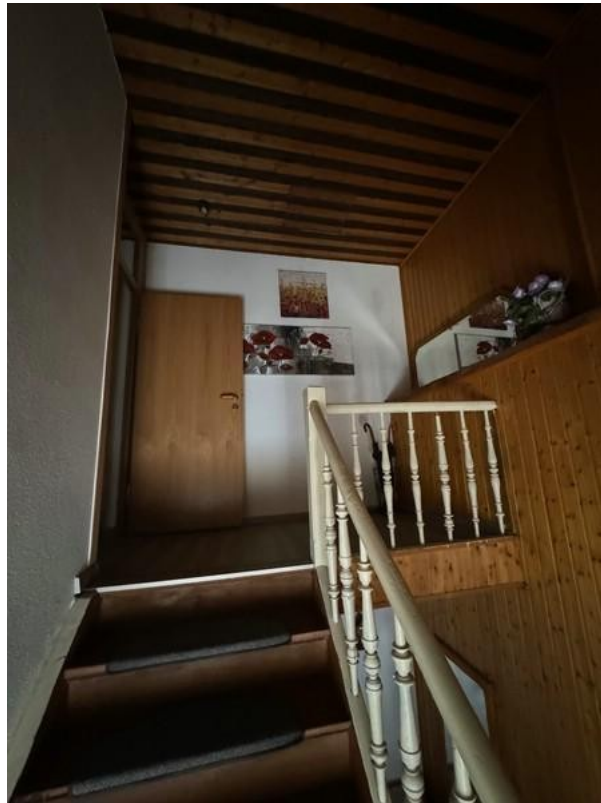
6 DG Innentreppe zum DG
