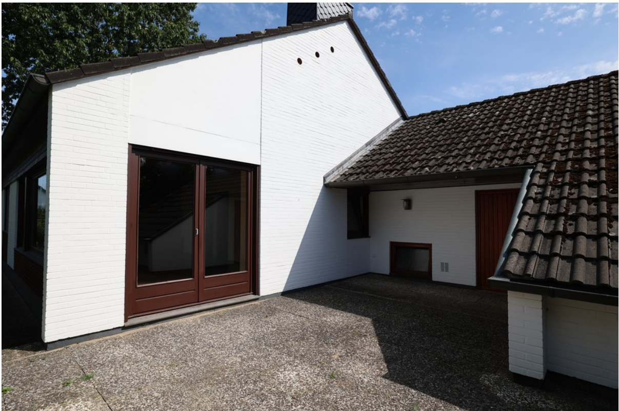
Große Terrasse mit überdachtetem
