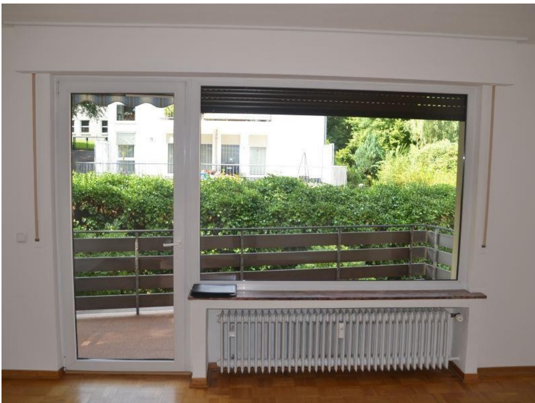
9 Raum rechts Balkon II
