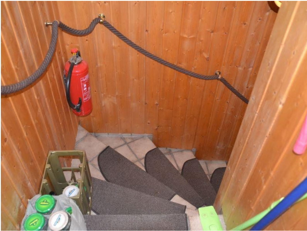
22 EG Treppe Keller II
