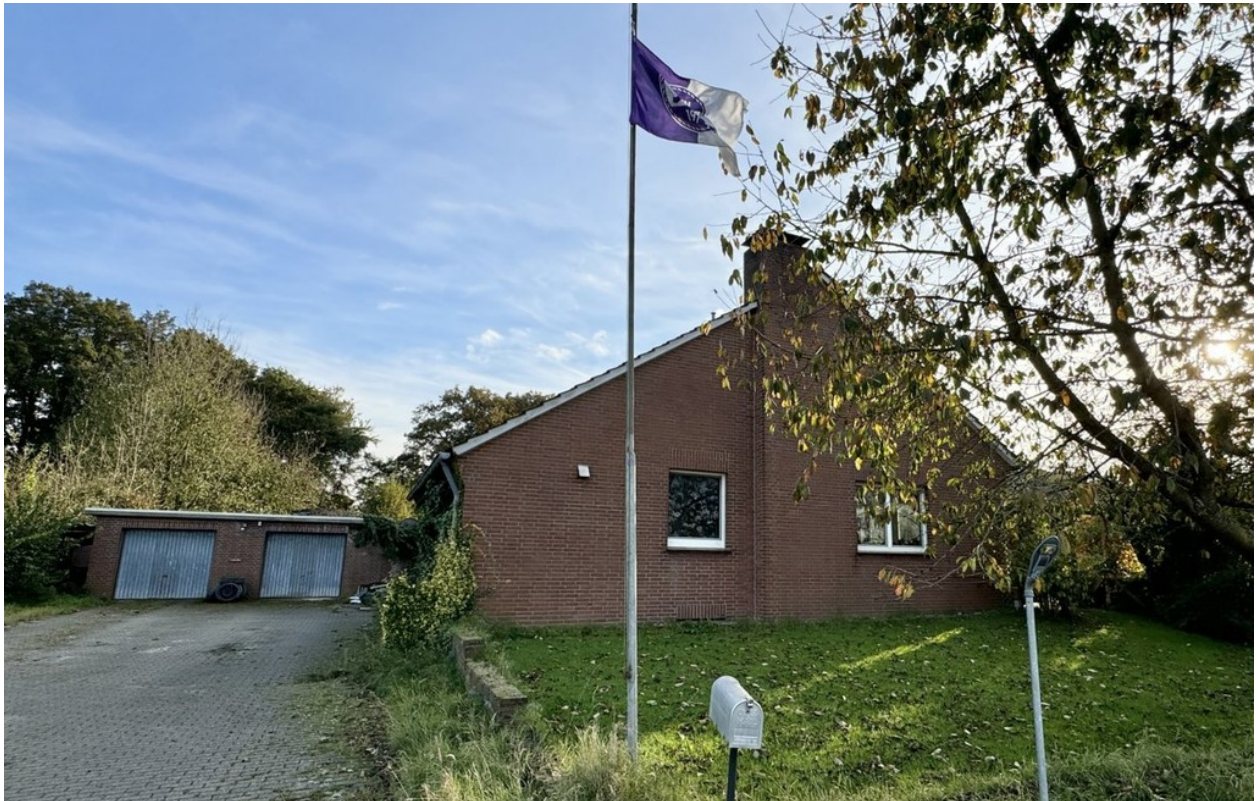
Nordseite mit Hof
