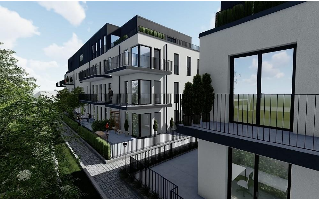
Gebäude A Eckansicht
