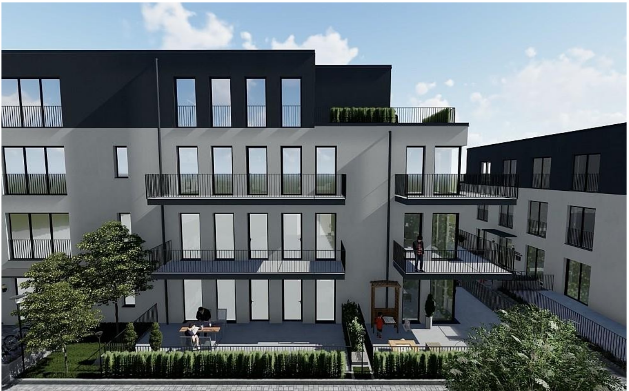
Haus A Eingang 2
