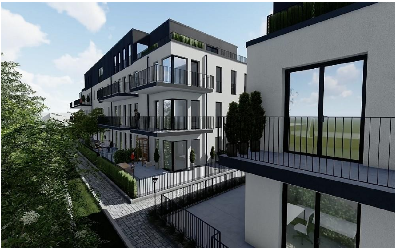
Gebäude A Eckansicht
