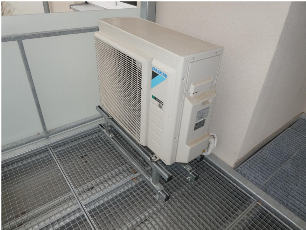
Wärmepumpe
