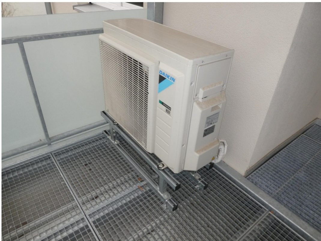
Wärmepumpe
