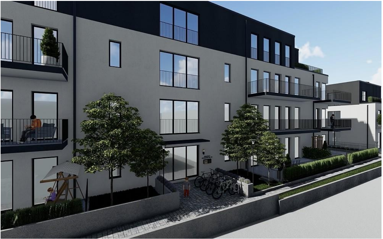
Gebäude A Eingang
