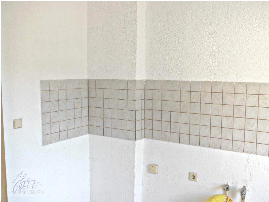
Erdgeschoss rechts - Küche
