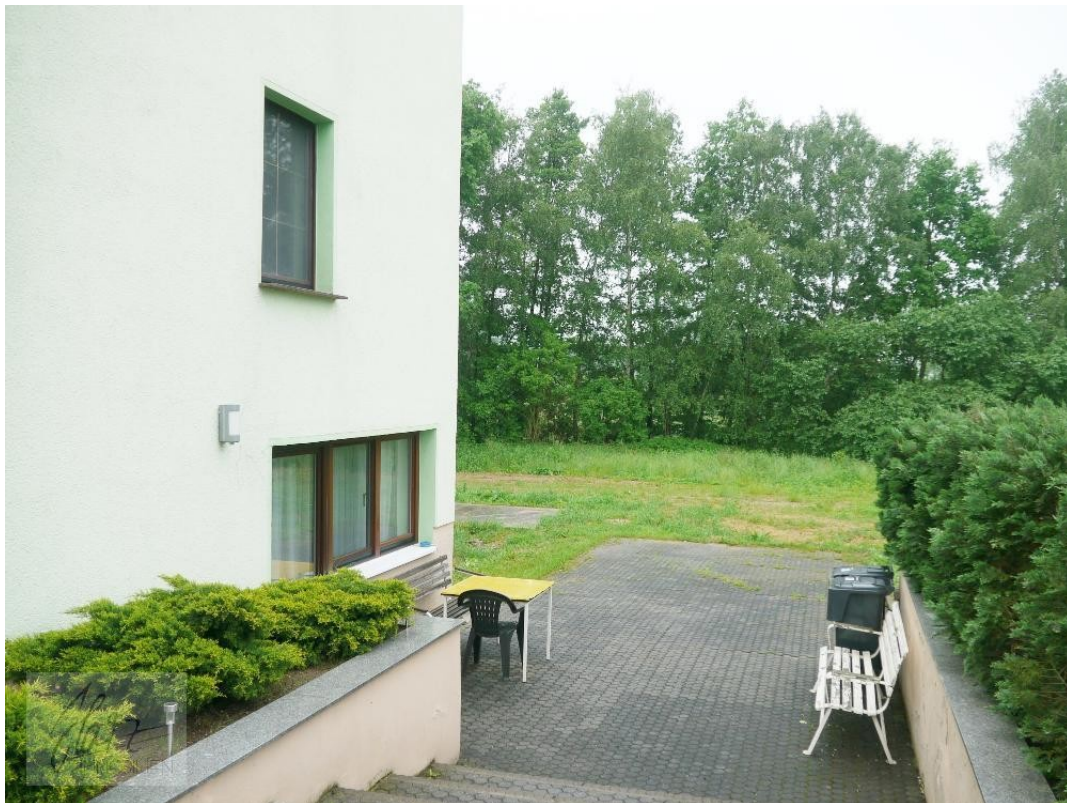
Zugang zu Souterrain-Wohnung
