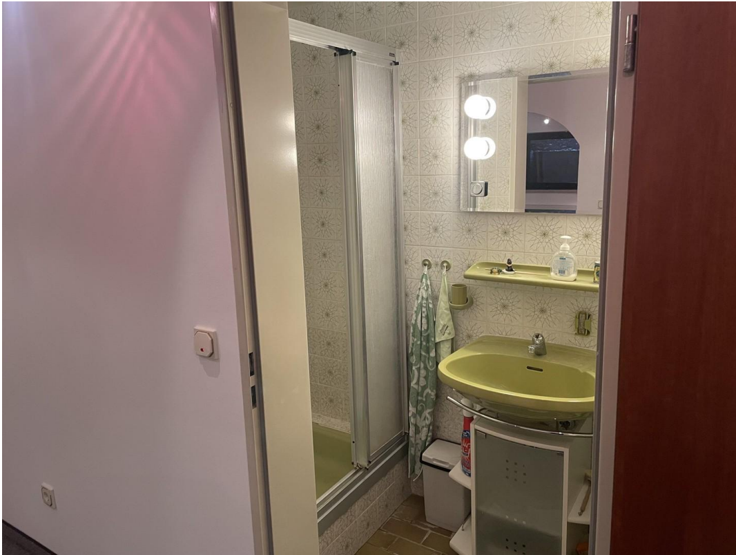
Dusche am Hobbyraum UG
