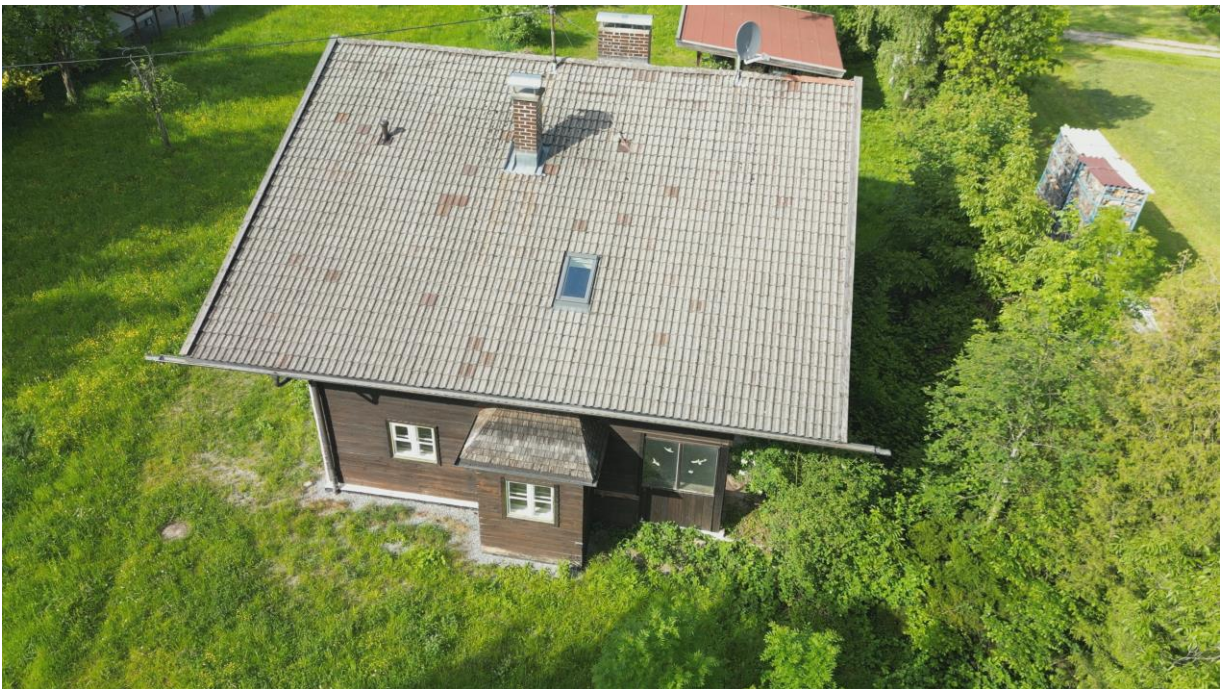
Abbildung 3 Wiesenweg12 Ansicht von Westen
