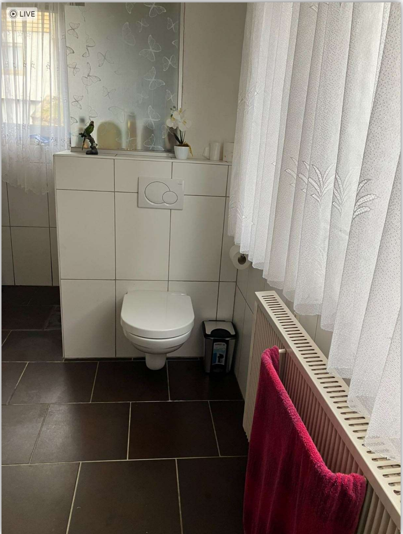
Wand WC mit Geberit Einbauspülkasten, Barrierefreie Dusche
