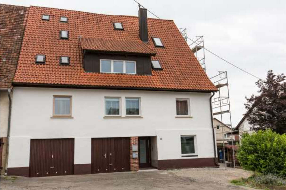
Hausansicht nach der Sanierung
