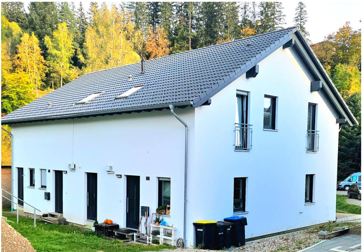
Hausabbildung – vor Fertigstellung des Außenbereichs
