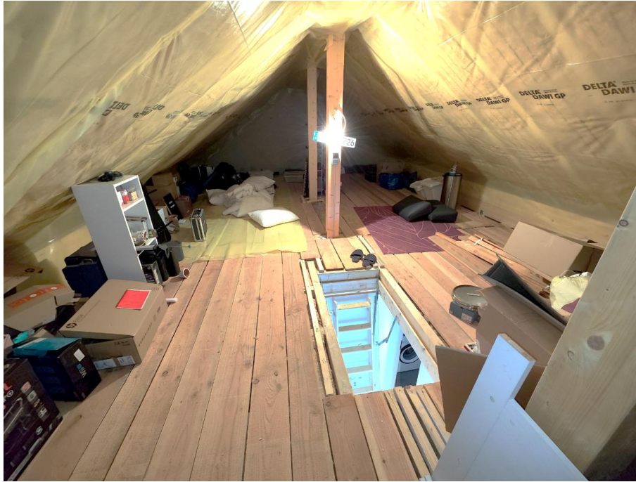
Dachboden Abstellraum – Beispielabbildung
