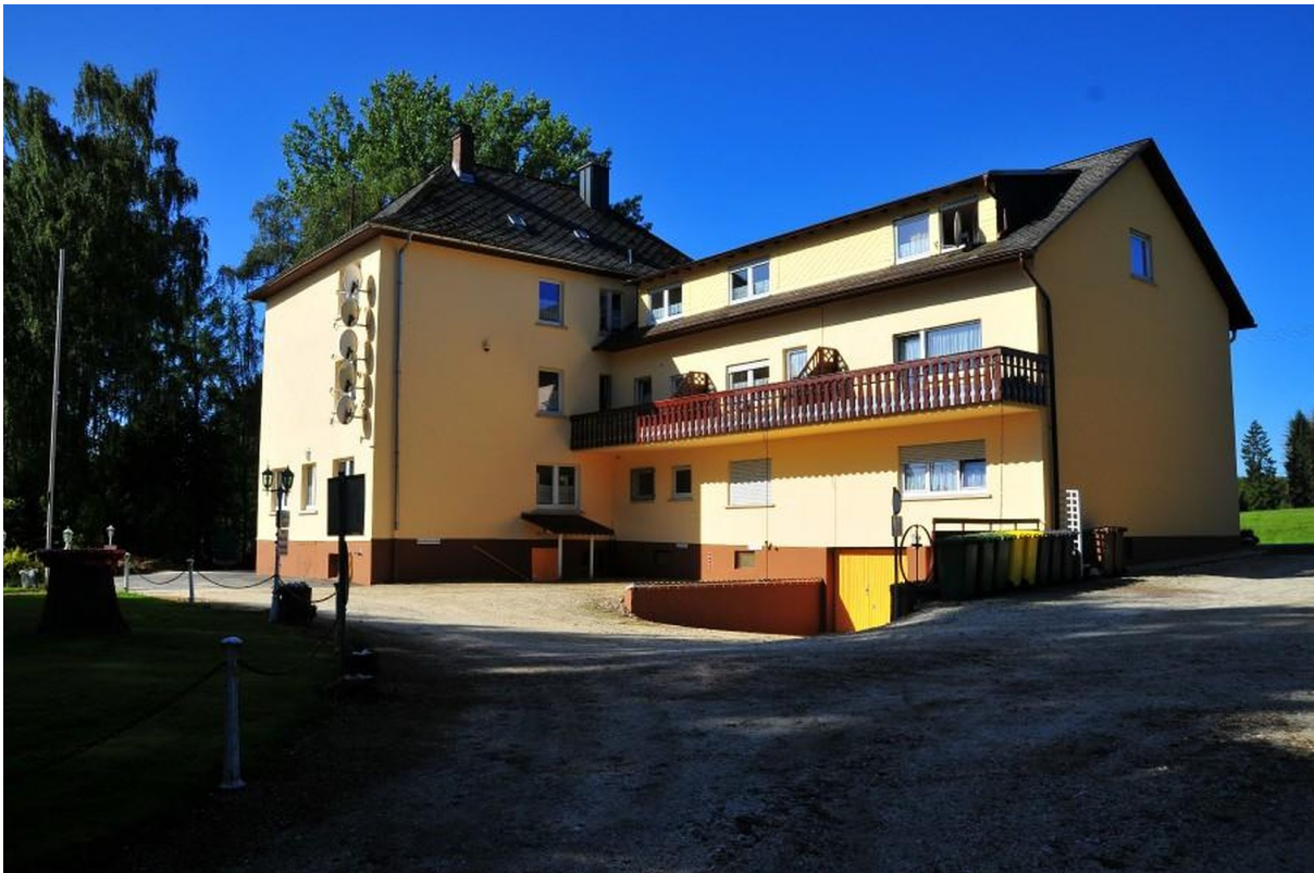
Hauptgebäude von Ost
