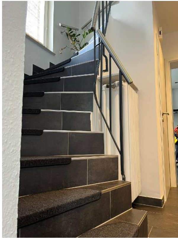
Treppe zum OG
