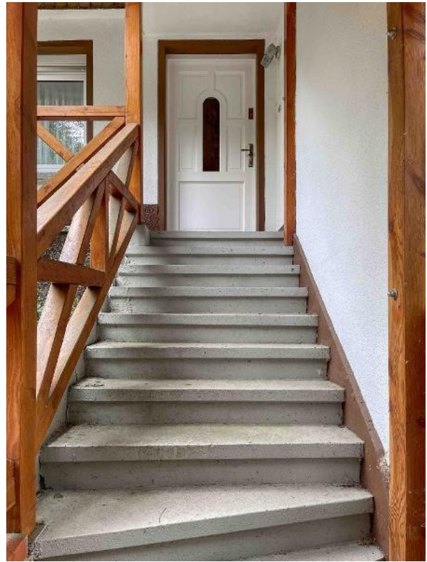
SB11 Aufgang zum Eingang
