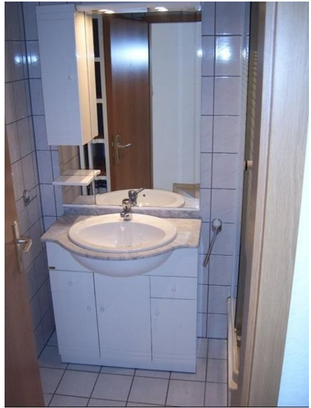
KB23 Anbau OG Bad
