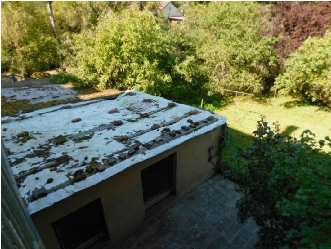
BB28 Anbau, Werkstatt
