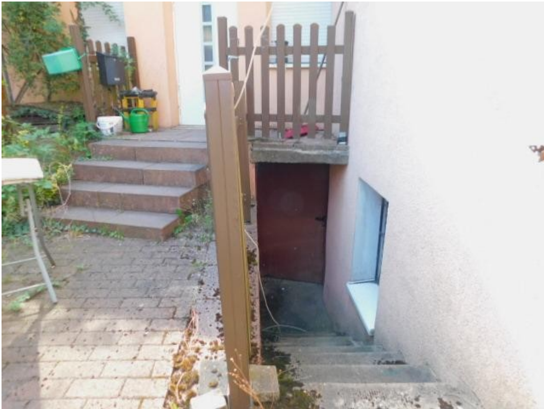
SB23 Zugang Keller Außen
