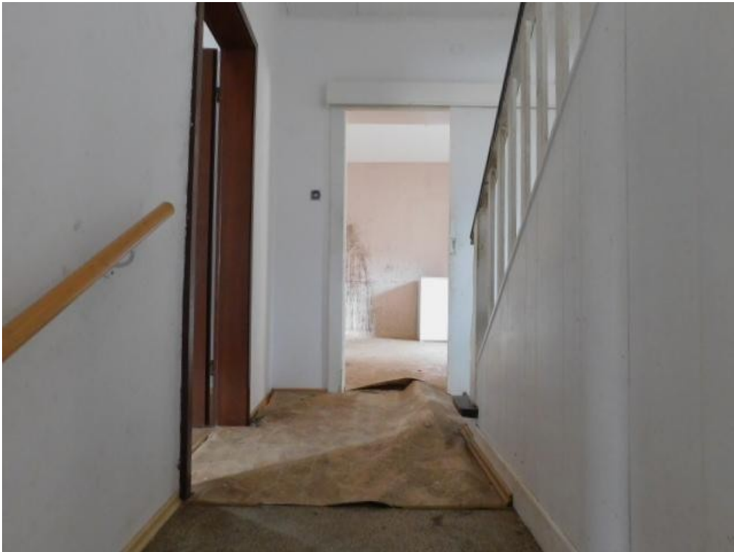
SB5 Hauseingang Diele
