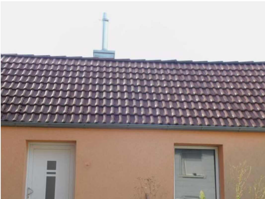
SB28 neues Dach
