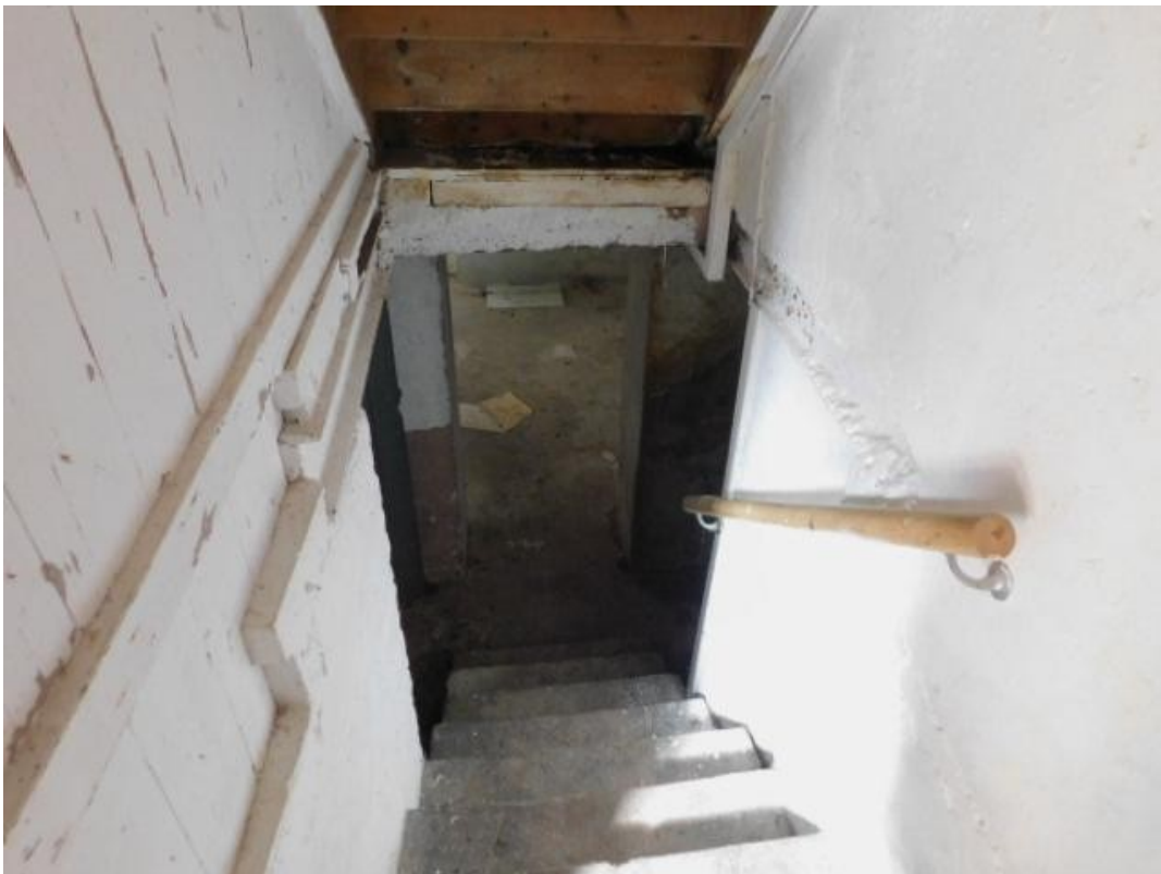
SB22 Zugang Keller Innen
