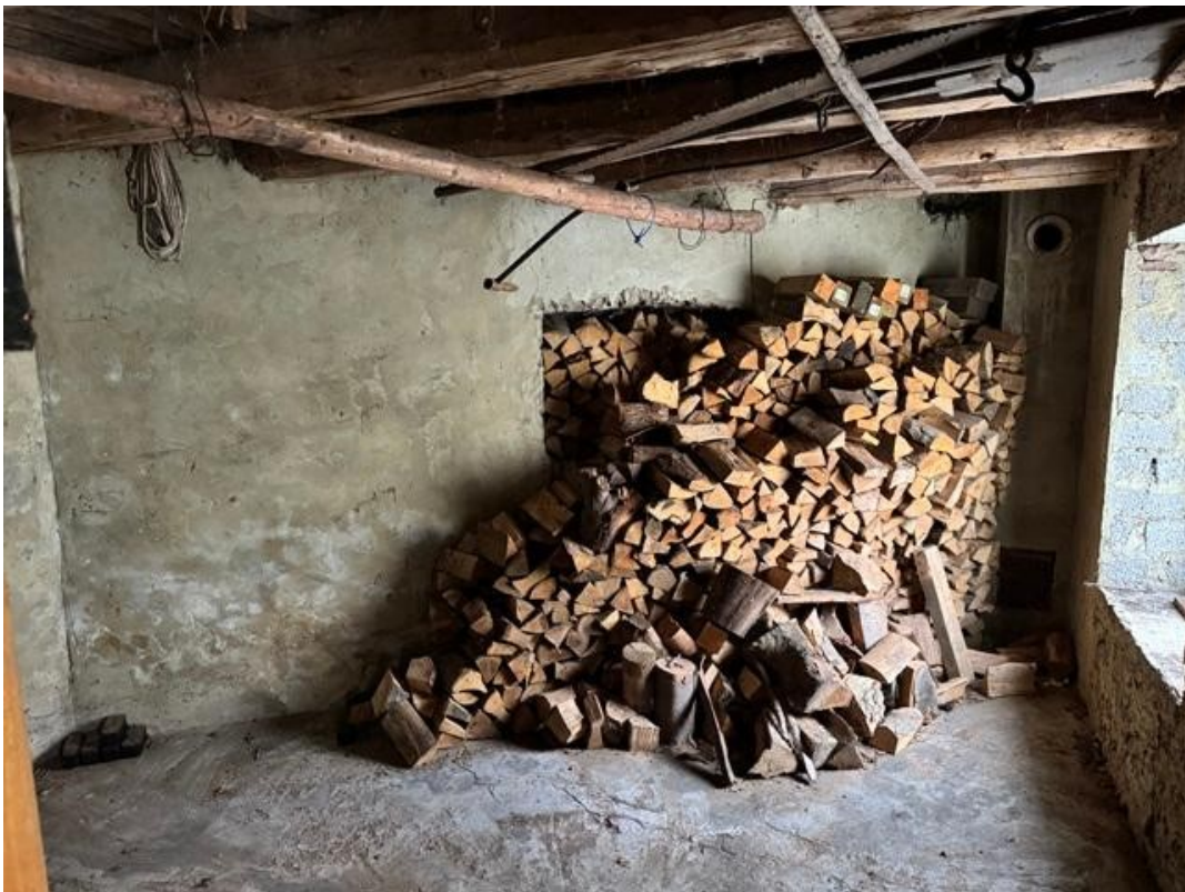
MB19-1 Brennstofflager Anbau
