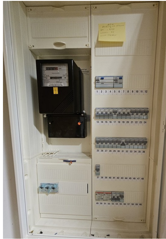
Sicherungskasten
