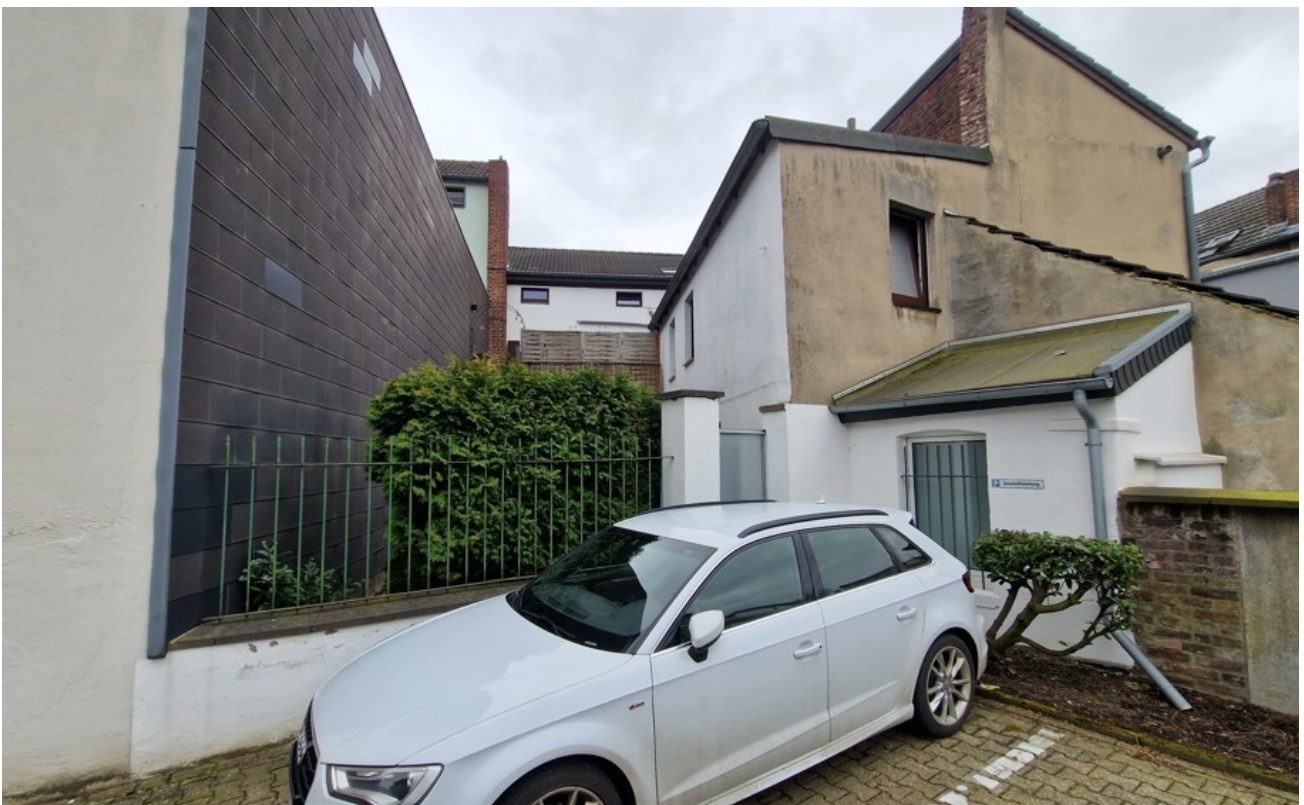
Hausrückseite / Zugangstüre In
