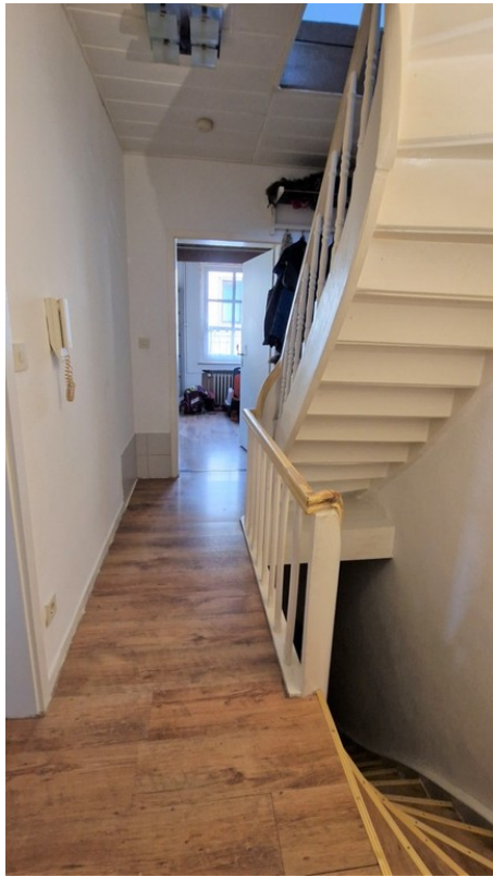
Treppe 1.OG - DG
