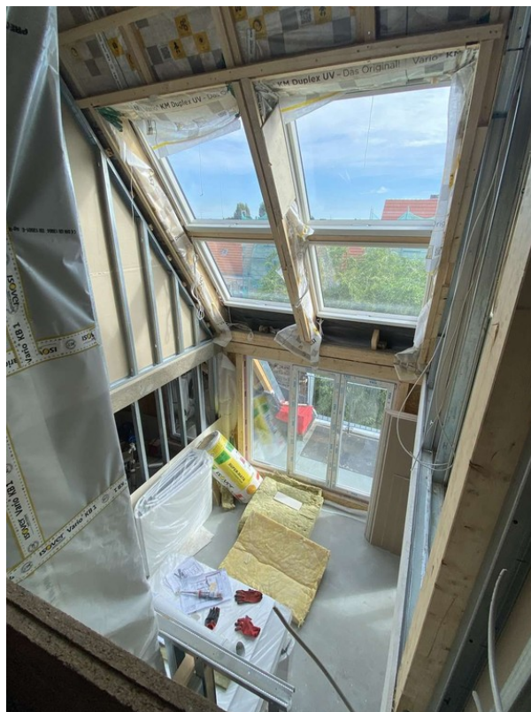
Foto Atrium im Rohbau
