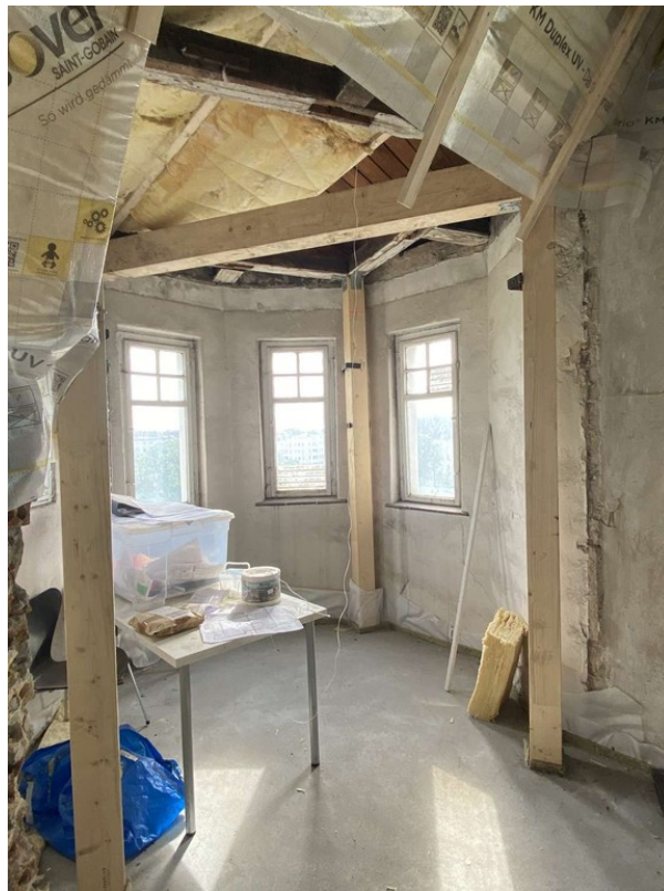
Foto Turmzimmer im Rohbau
