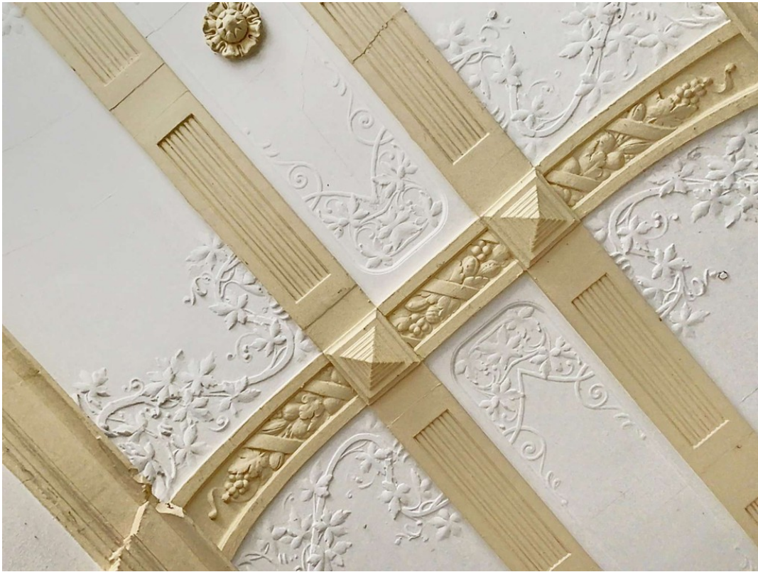
Detail Stuck im Hauseingang
